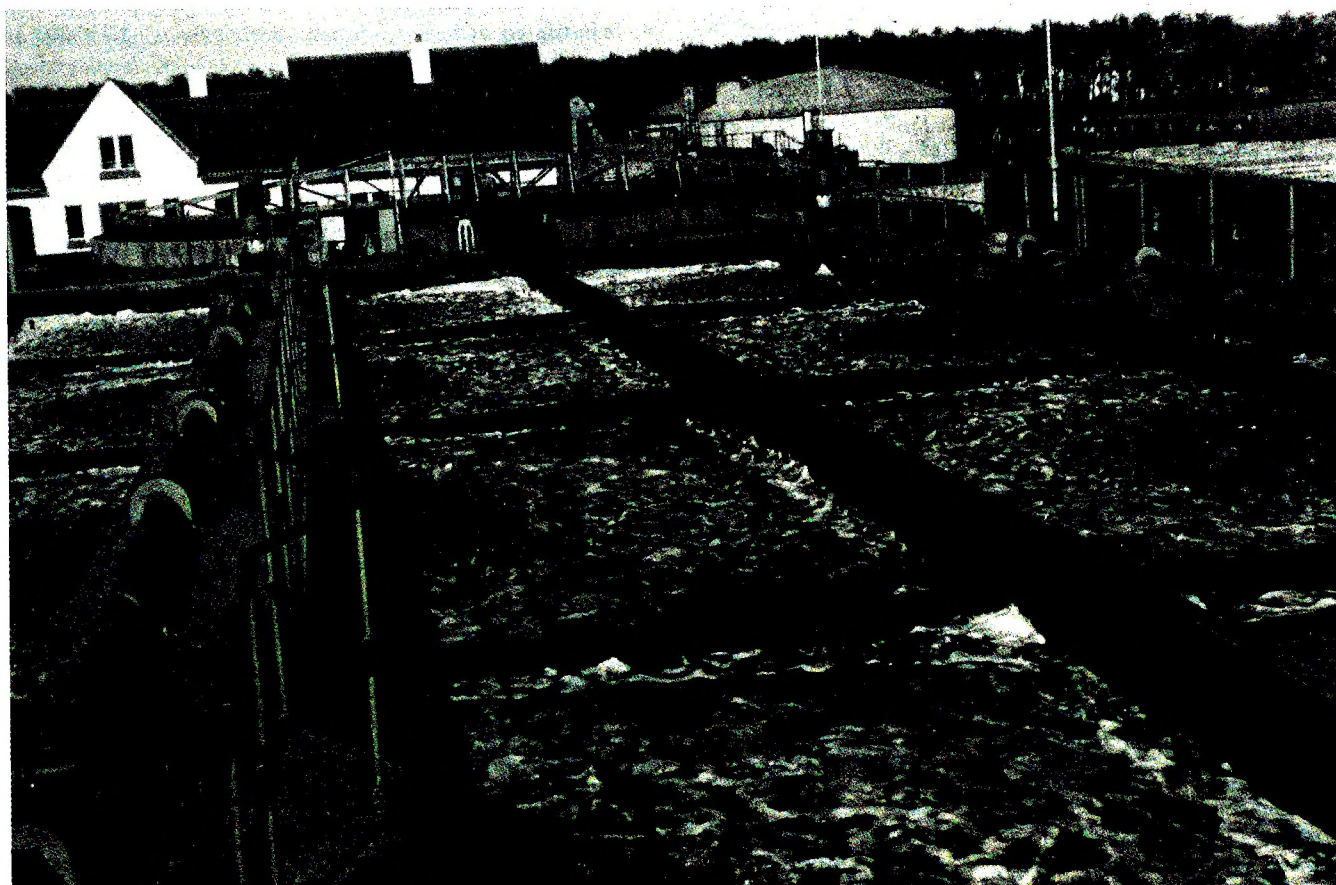
Foto Archief WZK : Zuiveringsinstallatie te Nieuwpoort
