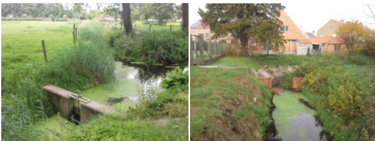
Foto links: stuw aan ZW-hoek fortdomein – foto rechts: stuw thv. pompstation Aquafin aan westrand
