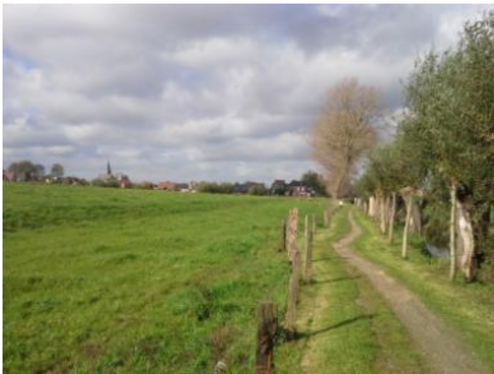
Bij de restauratie in 2013 werd de oorspronkelijke buitengracht geaccentueerd door een niveauverschil met het glacis (zie kleine talud aan linkerzijde grasland)
