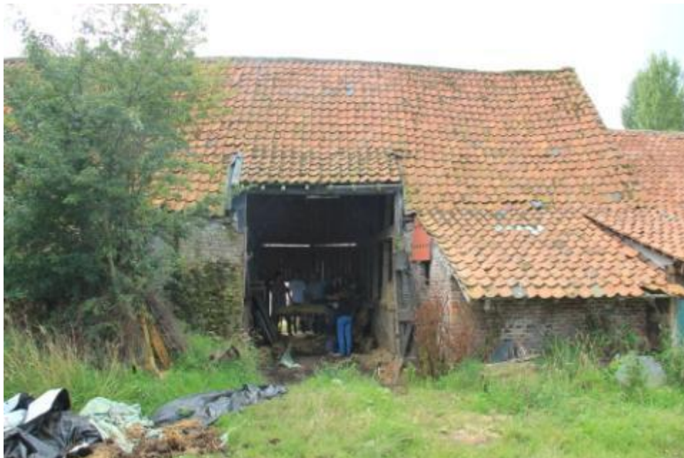
Zicht op het oudste deel van de schuur achteraan
