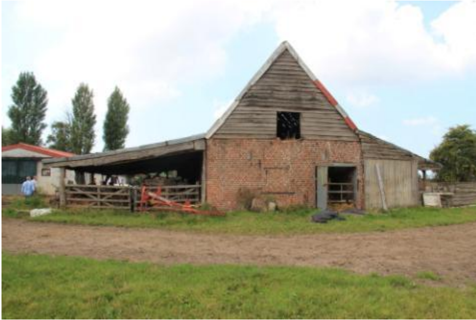
Zicht op de oostzijde van de schuur (recenter deel)
