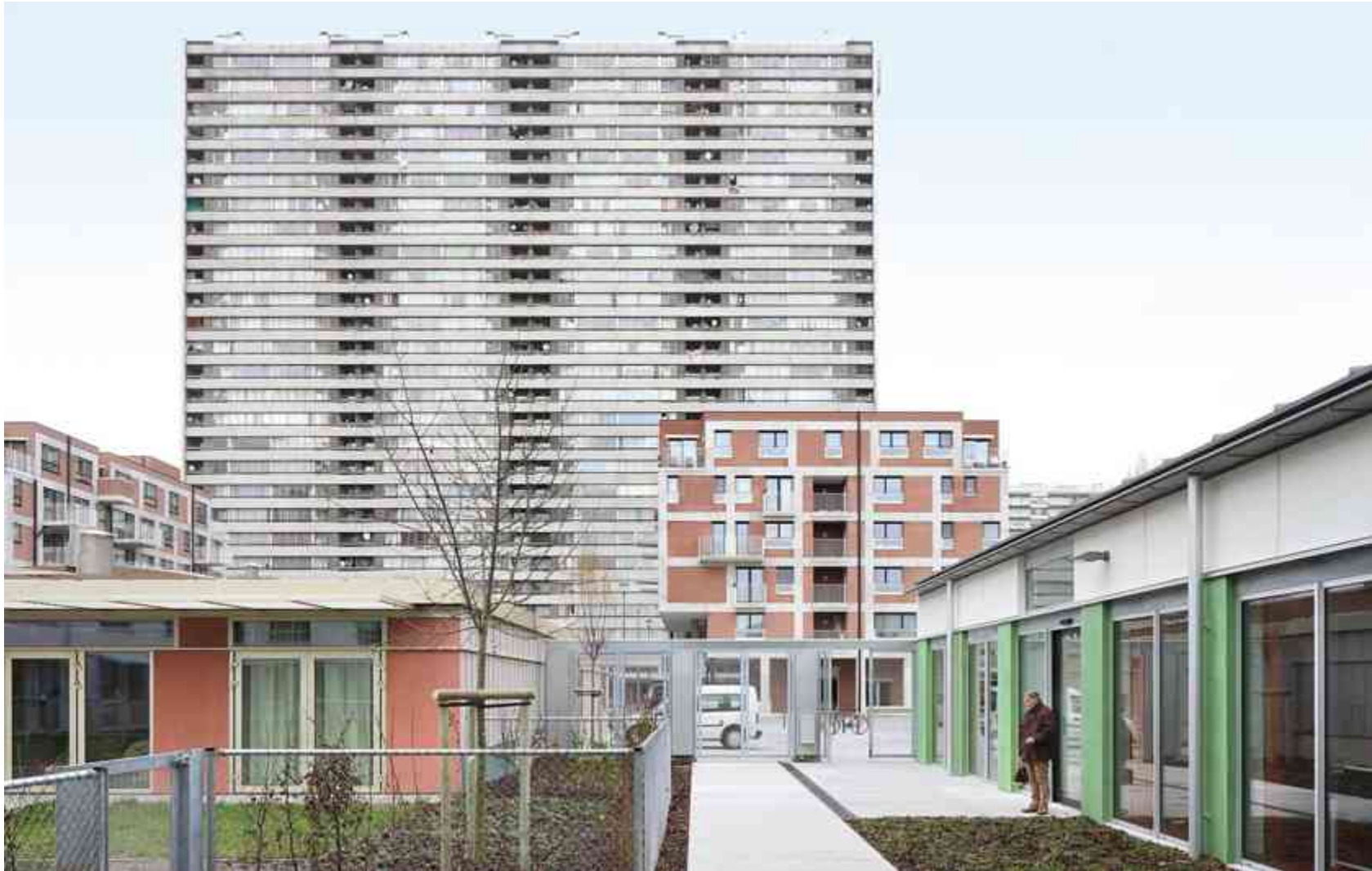
IGLO project, Linkeroever Antwerpen, door DeSmetVermeulen architecten
